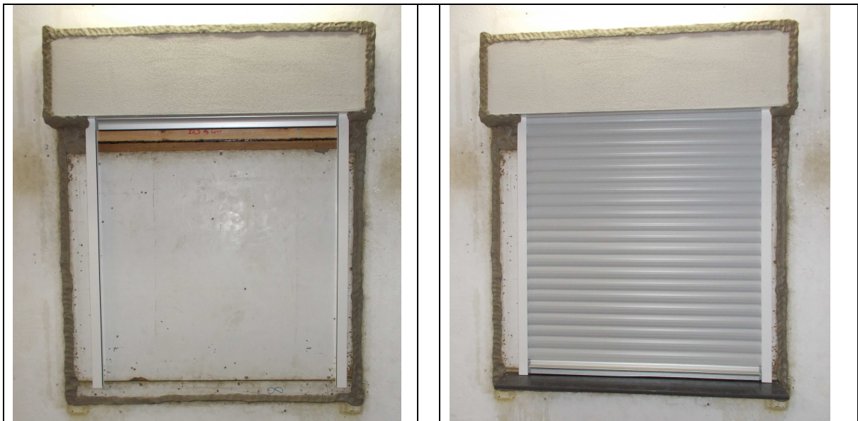
Bild 1 Ansicht im Senderraum: links Panzer oben, rechts Panzer unten*
